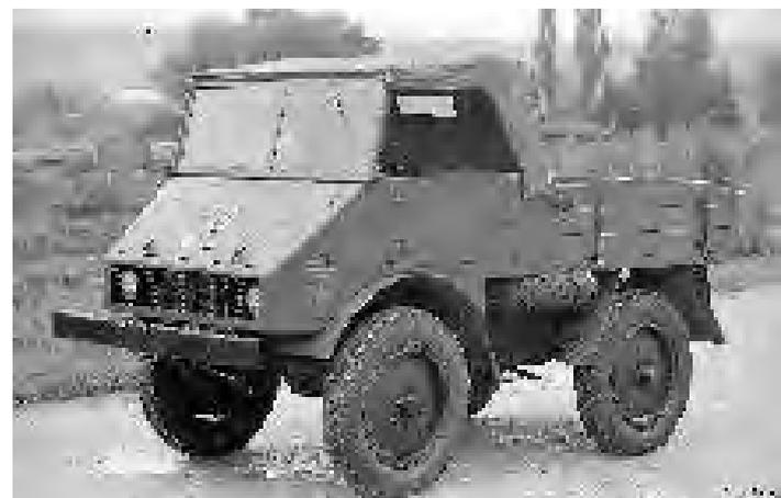
Dieser Unimog-Prototyp war schon sehr nahe am späteren Serienfahrzeug. Im Fahrerhaus mit Verdeck ist eine Heizung verbaut.
